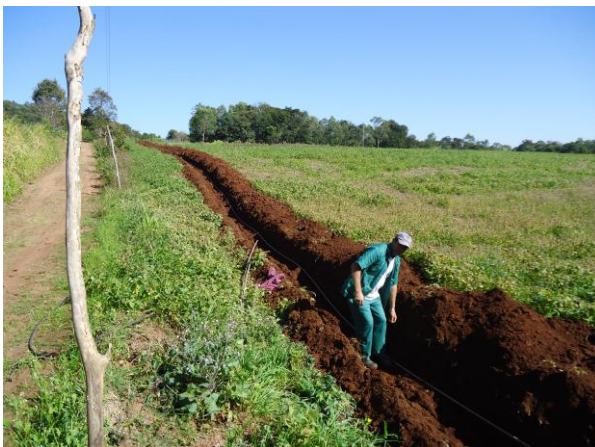
FOTO 05 e 06 – Implantação da rede água dos poço artesiano.
