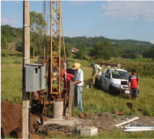
FOTO 01 e 02 – Perfuração de poço artesiano no interior
