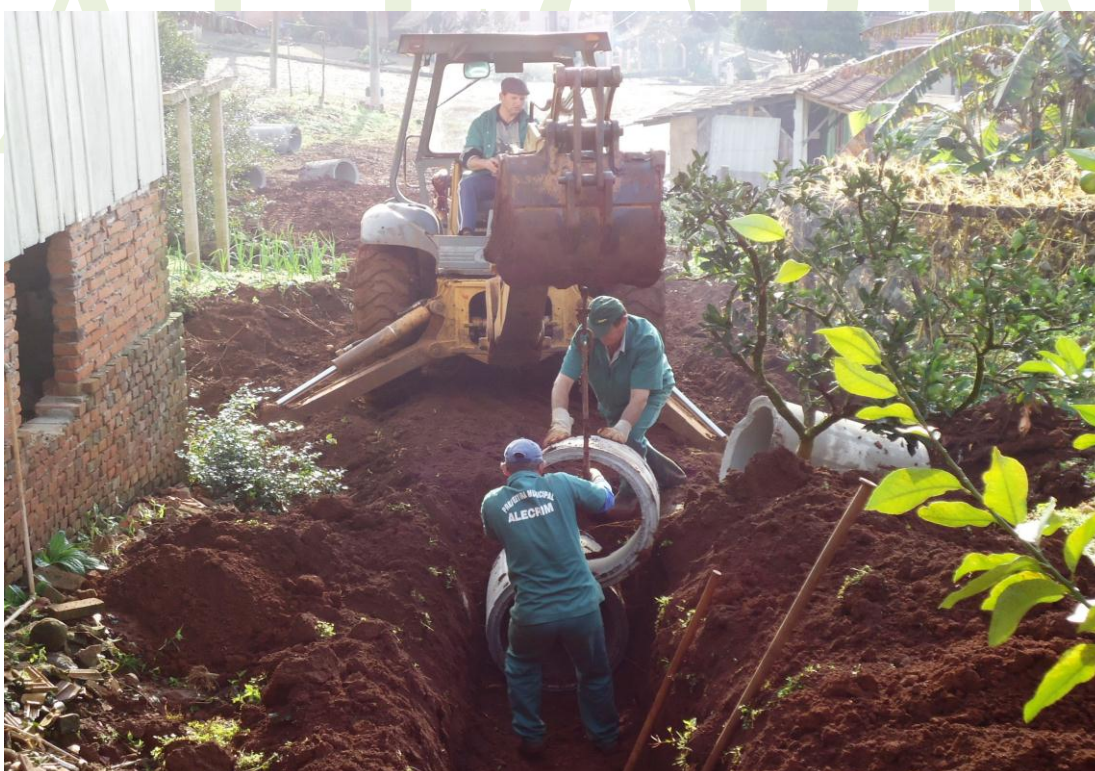
FOTO 02 – Tubulação drenagem urbana de águas pluviais
