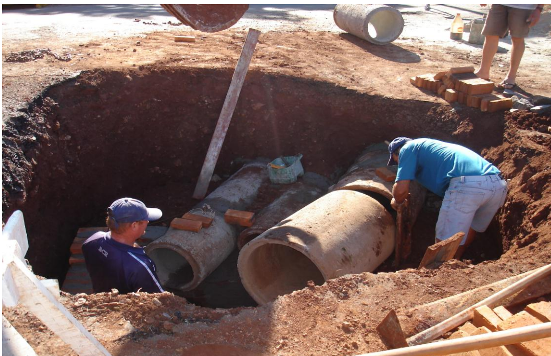
FOTO 01 – Tubulação drenagem urbana de águas pluviais
